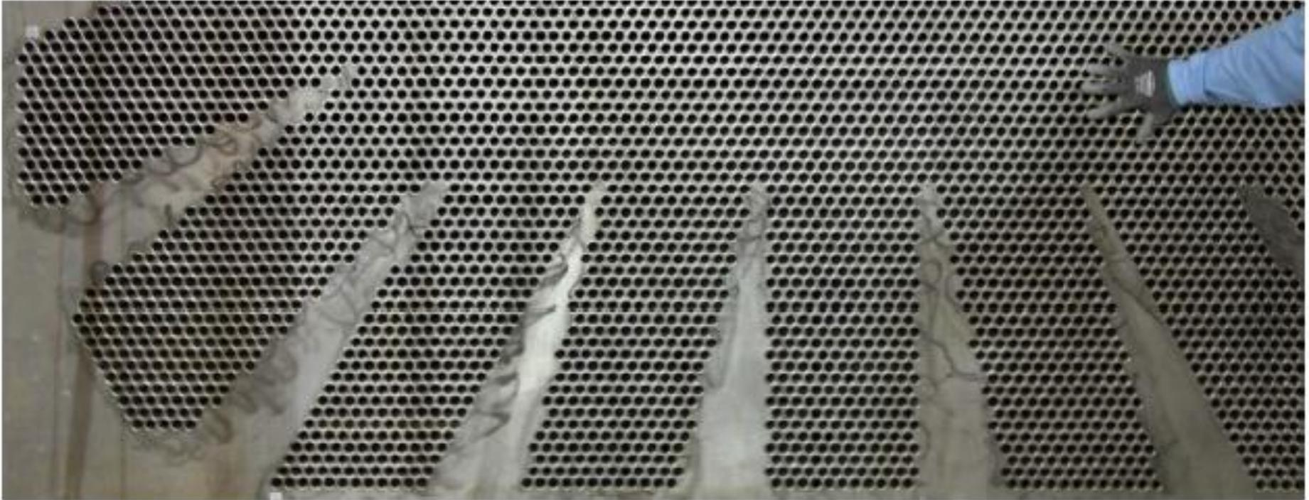
Faisceaux du condenseur dans lesquels circule l'eau de Gironde
